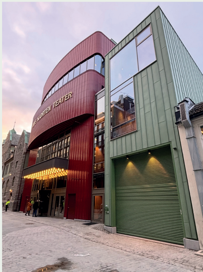
Sidefløyen og scenetårnet er kledd i ferdigpatinert kobber.
